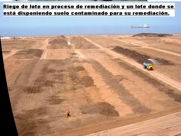
Homogenización y Aireación de suelo contaminado en un lote.
