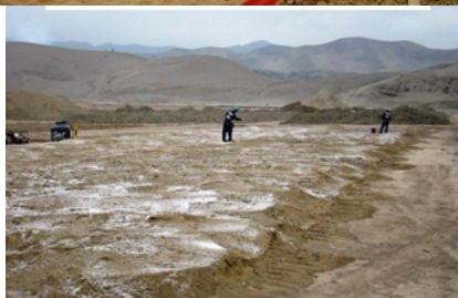
Homogenización y Aireación de suelo contaminado en un lote.
