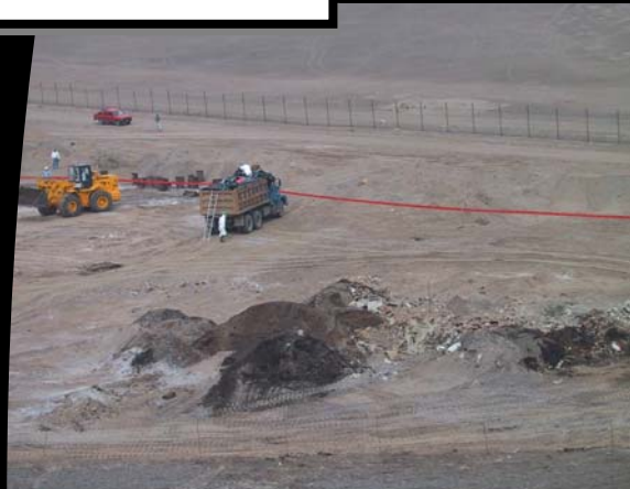
Proceso de Zarandeo de Suelos contaminados, luego de su excavación.
