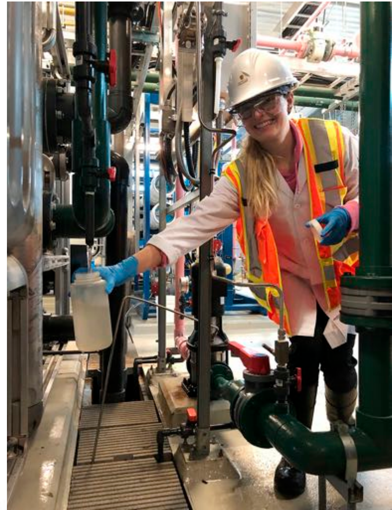
Sampling UF Effluent
